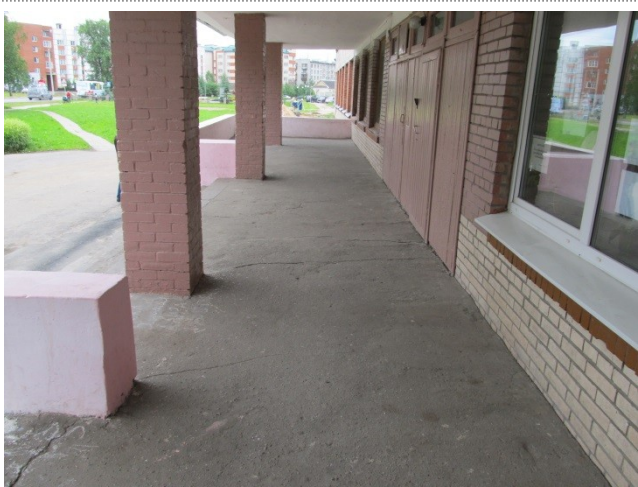
Фото 5 Входная площадка (перед входной дверью)
