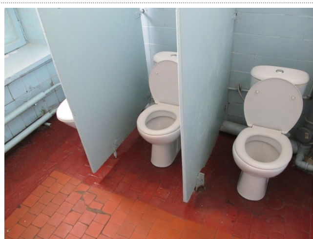
Фото 26 Туалетная комната (кабины)
