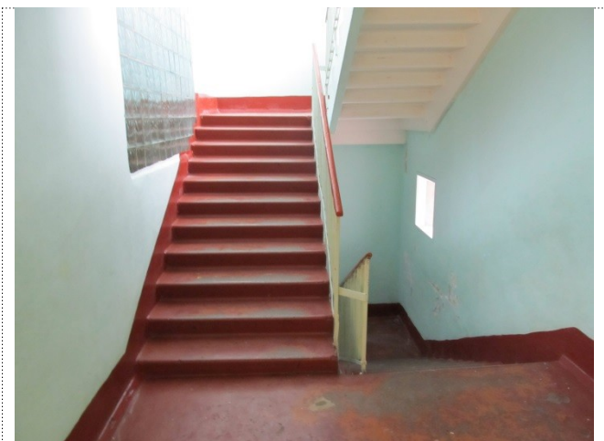
Фото 15 Внутренние лестницы (междуэтажные)
