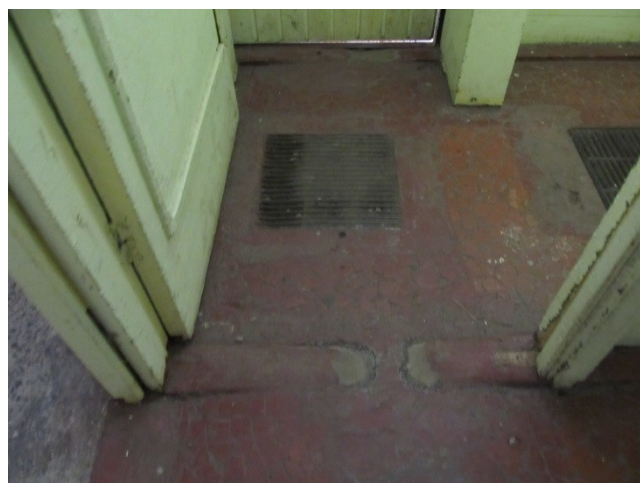
Фото 8 Дверь внутренняя (входная)
