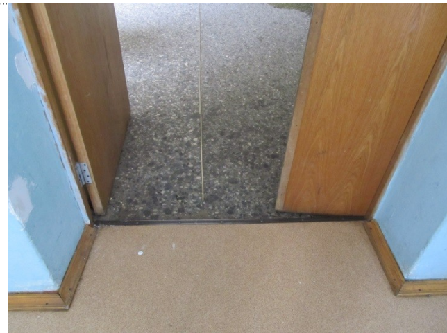
Фото 14 Внутренние лестницы (междуэтажные)
